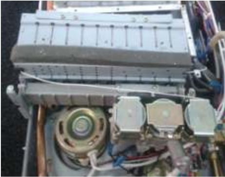
9-Retirar os 2 para parafusos que fixam o distribuidor de gás ao conjunto queimador;
